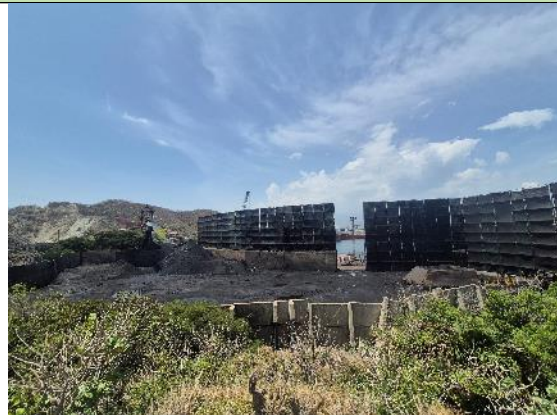
Fotografía 42. Muros delimitación Patio Ancón
