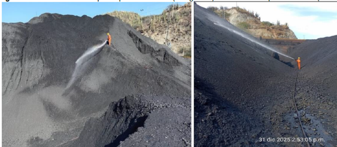
Fotografía 12. Control activo en patios por vía húmeda (Mangueras) – Patios de Acopio de Carbon (Carbosan)
