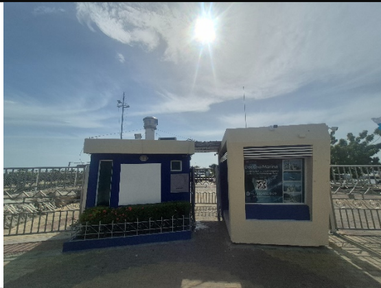
Fuente: Equipo de Seguimiento Ambiental ANLA, 25/06/2026
